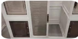
7. Installing door panels
