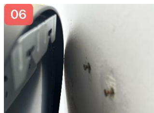
将挂钩中心点对准螺丝悬挂
