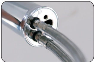
Connectez le chaud tuyau d'eau froide et serrer
