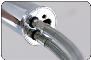
Conectar el caliente tubería de agua fría y apretar
