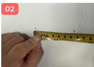
在两个中心点的水平线上按照测量距离标记好墙体打孔位置
