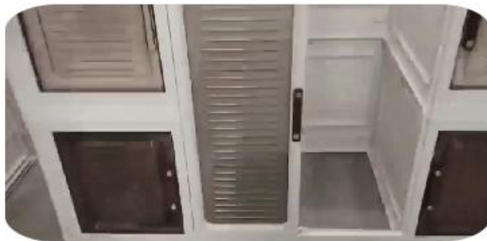
7.Installing door panels
