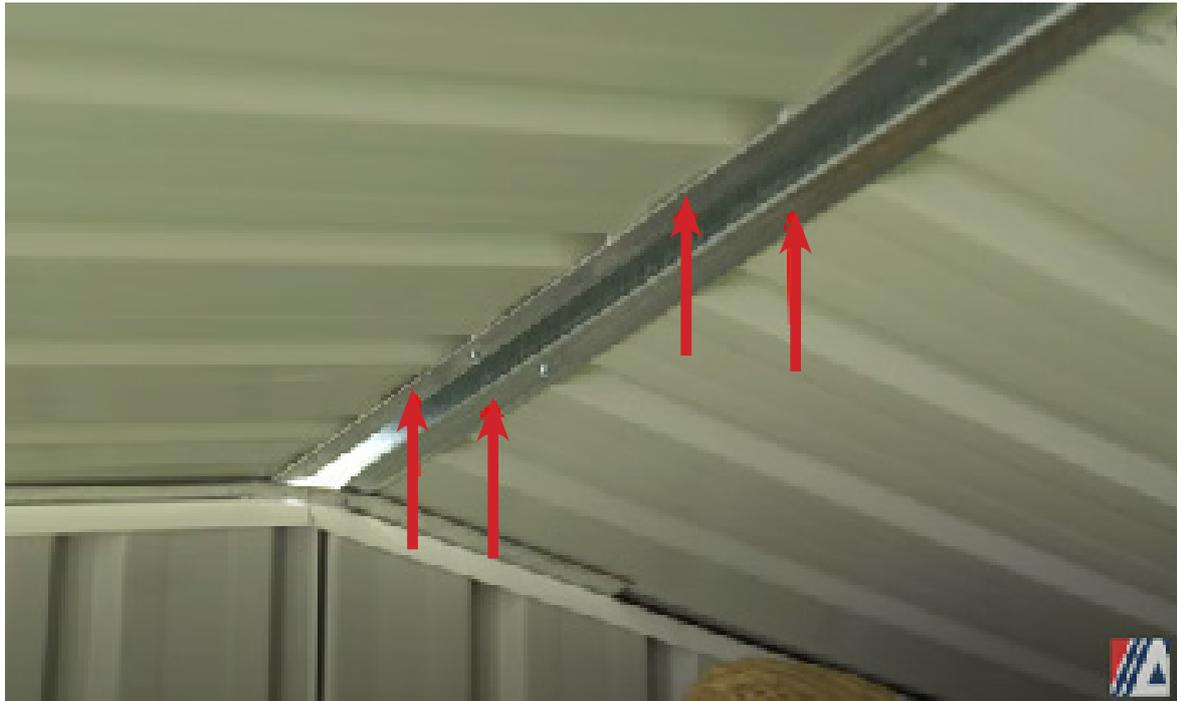
CES POSITIONS N'ONT PAS DE TROUS PRÉ-PERFORÉS, UTILISEZ DONC LE FORET FOURNI POUR PRÉPERCER DES TROUS À TRAVERS LA POUTRE FAITIÈRE, LE CANAL DU PANNEAU DE TOIT À L'INTÉRIEUR ET LA TÔLE DE TOIT.
