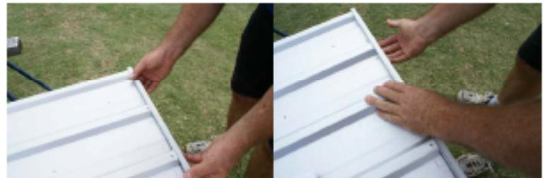
Positionner les feuilles sur les poutres, les trelles ou partiellement sur le bord de la dalle de béton.
