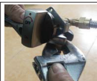
Déposer le tuyau de propane
