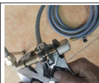
Installer le tuyau de gaz
