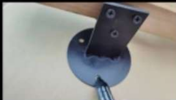
2.在墙上做记号 MARK ON THE WALL
