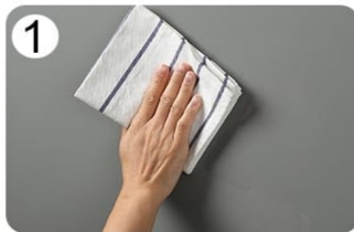
1 Pulire bene il muro
