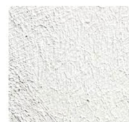
Muro di calce
