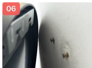
将挂钩中心点对准螺丝悬挂
